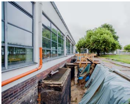
Eine Abböschung des Geländes soll für mehr Licht im Untergeschoss des Gebäudes führen.
