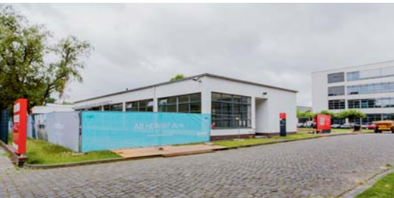
Beginn der Bauarbeiten im ehemaligen Pförtnerhaus im Frühjahr 2016.
