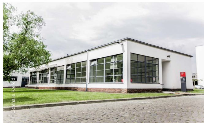
Außenansicht ehemaliges Pförtnerhaus und neuer Deutschlandsitz von Interface
