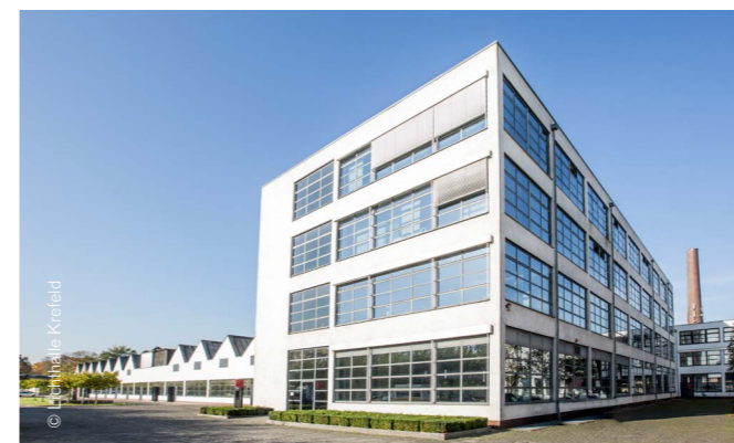
Das HE-Gebäude mit angrenzender Shedhalle
